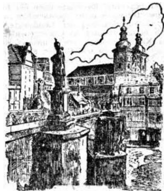
Neiße-Brücke in Glatz/Schlesien
